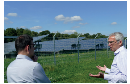
Besichtigung Anlage Heppenheim
